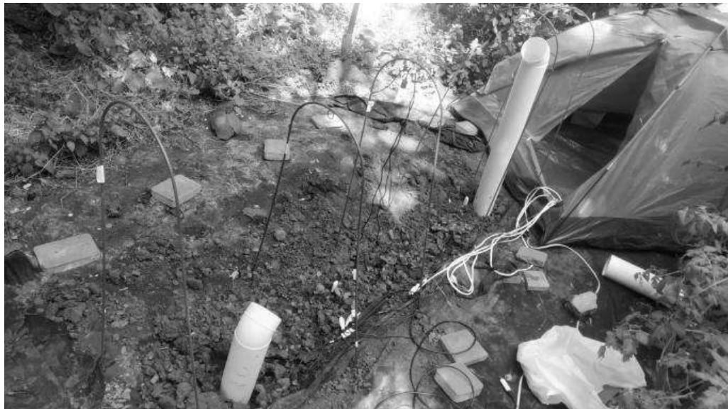
Рис. 2. Елементи монтажу теплиці: вигляд регенератора в ґрунті
