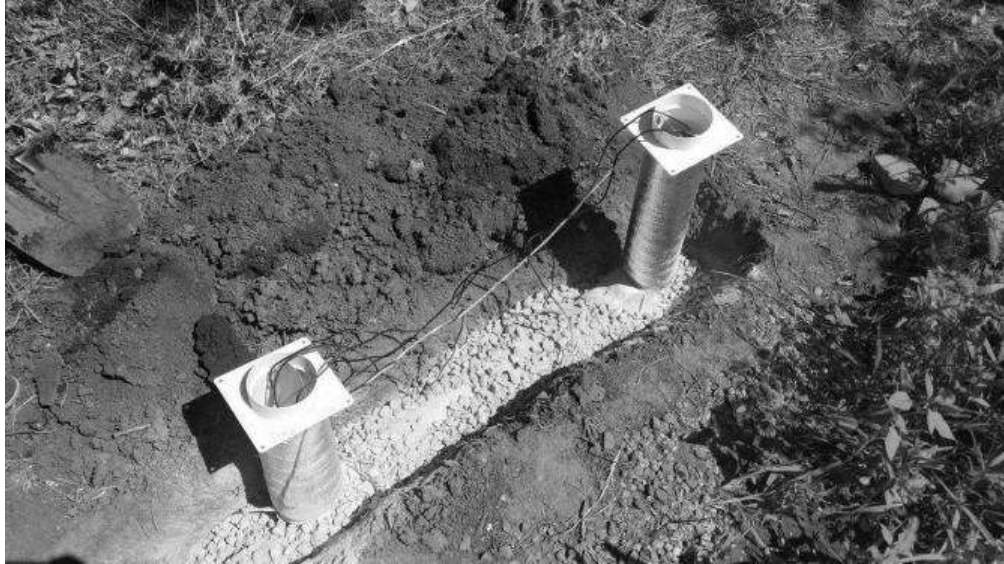
Рис. 1. Встановлення ґрунтового регенератора
