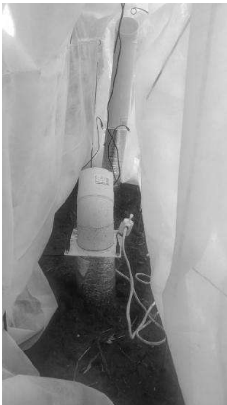
Рисунок 4. Підготовка ґрунтового регенерації до роботи
